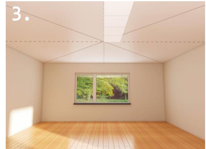
Stropní desky pokládejte v pravém úhlu ke stěnám, přičemž okraj desky začněte pokládat od středu stropu. Další desky lepte v řadách. Stropní desky s označením na zadní straně se ukládají ve stejném směru.
