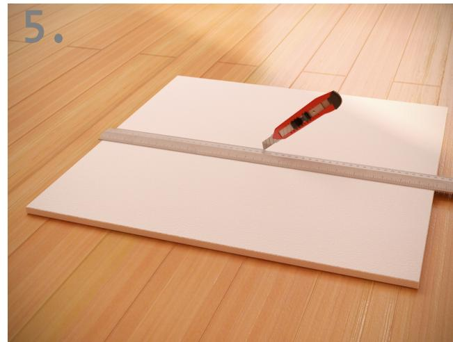
Stropní desky můžete upravit na požadovaný rozměr pomocí olamovacího nože.
